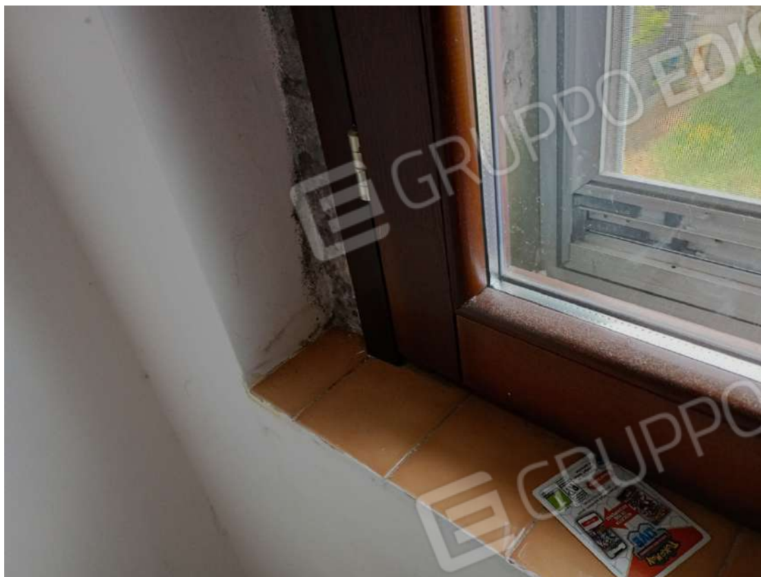
Foto 14_particolare infisso esterno
