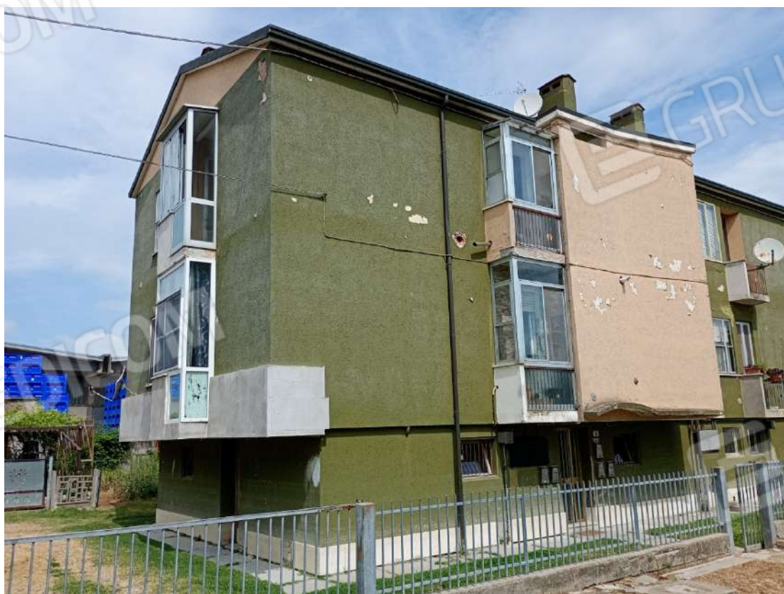
Foto 02_prospetto principale e laterale
