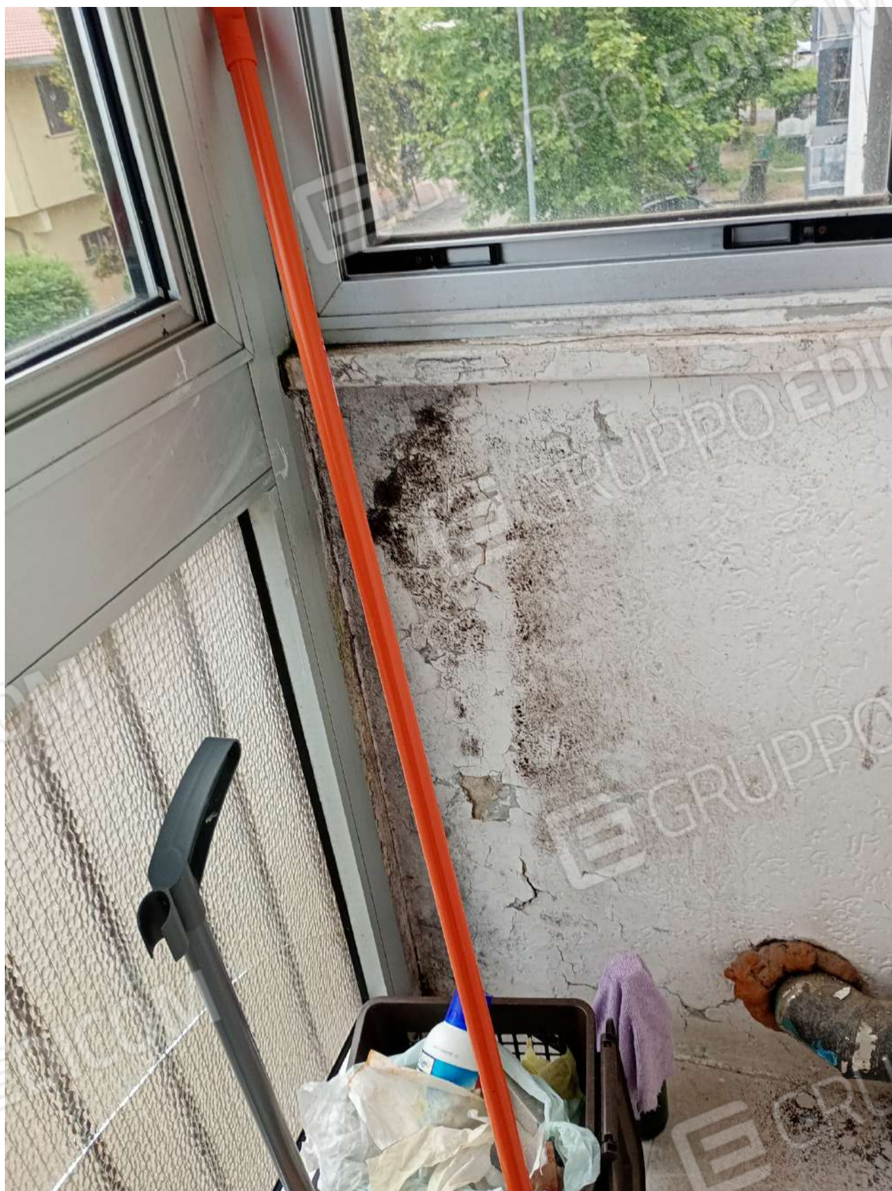
Foto 28_particolare chiusura balcone
