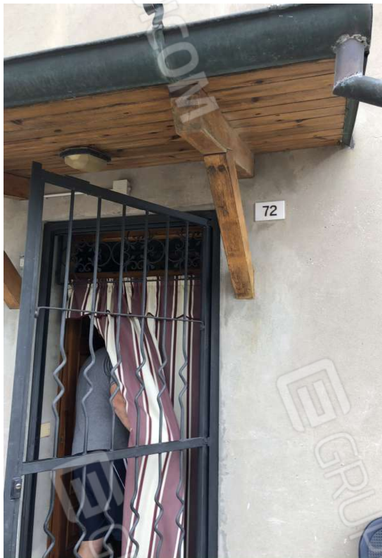
Foto 29: Particella 105, Subalterno 2, piano T
