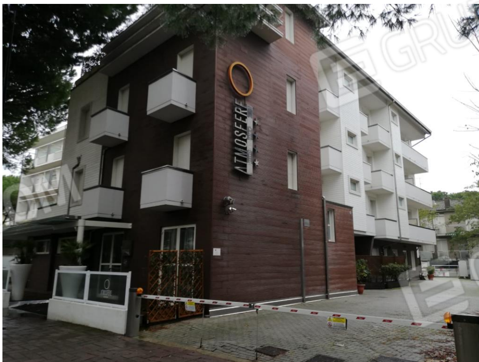
Vista del prospetto Nord-Ovest – particolare accesso carrabile
