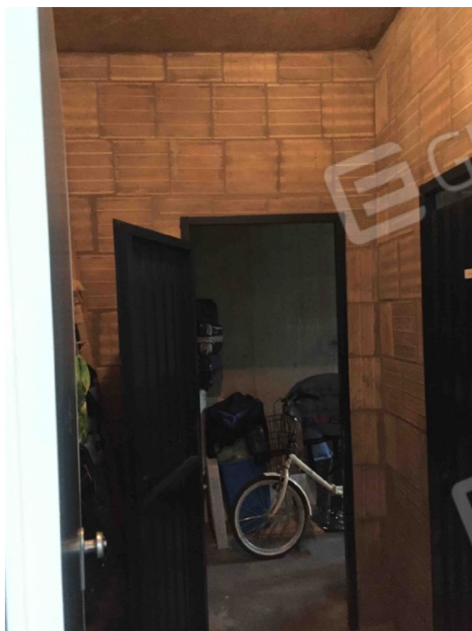
Ingresso cantina/ripostiglio al piano terra
