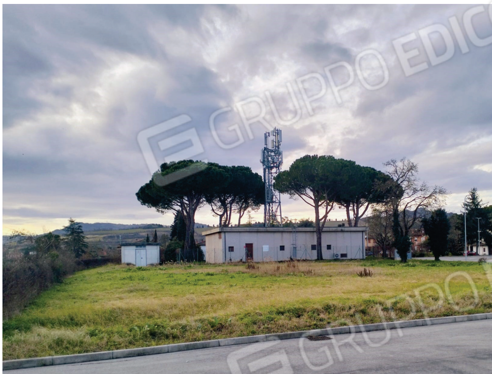
VISTA LOTTO 7 DA VIA ALIGHIERI
