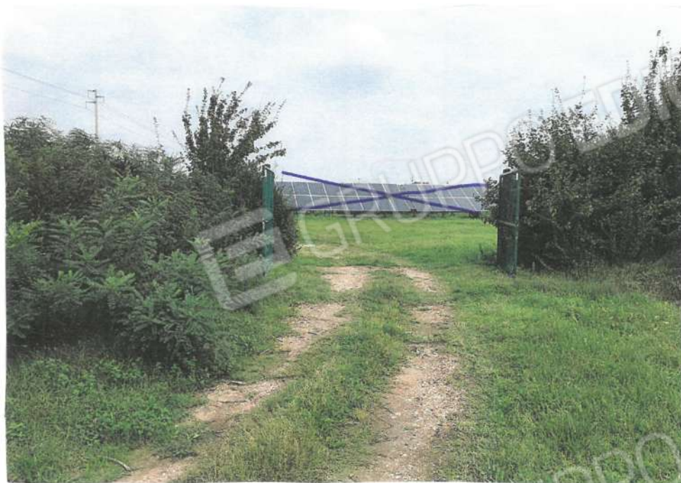
3- VISTA PAPP. 291, OGGETTO DI RIGMORAMENTO E' L'AREA E NON IL SOPRASTANTE IMPIANTO FOTOVOLTAICO
