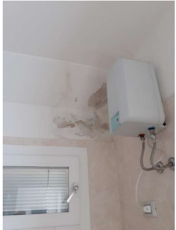
SUB 6 INTERNO: BAGNO E PARTICOLARI PROBLEMATICHE UMIDITA'
