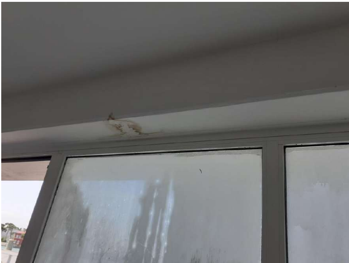
SUB 6 INTERNO: BAGNO E PARTICOLARI PROBLEMATICHE UMIDITA'
