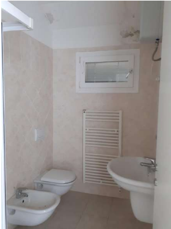
SUB 6 INTERNO: BAGNO E PARTICOLARI PROBLEMATICHE UMIDITA'
