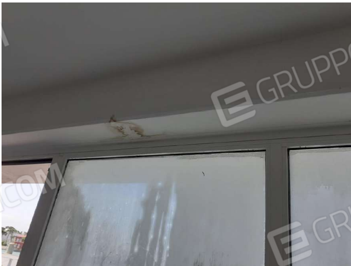
SUB 6 INTERNO: BAGNO E PARTICOLARI PROBLEMATICHE UMIDITA'
