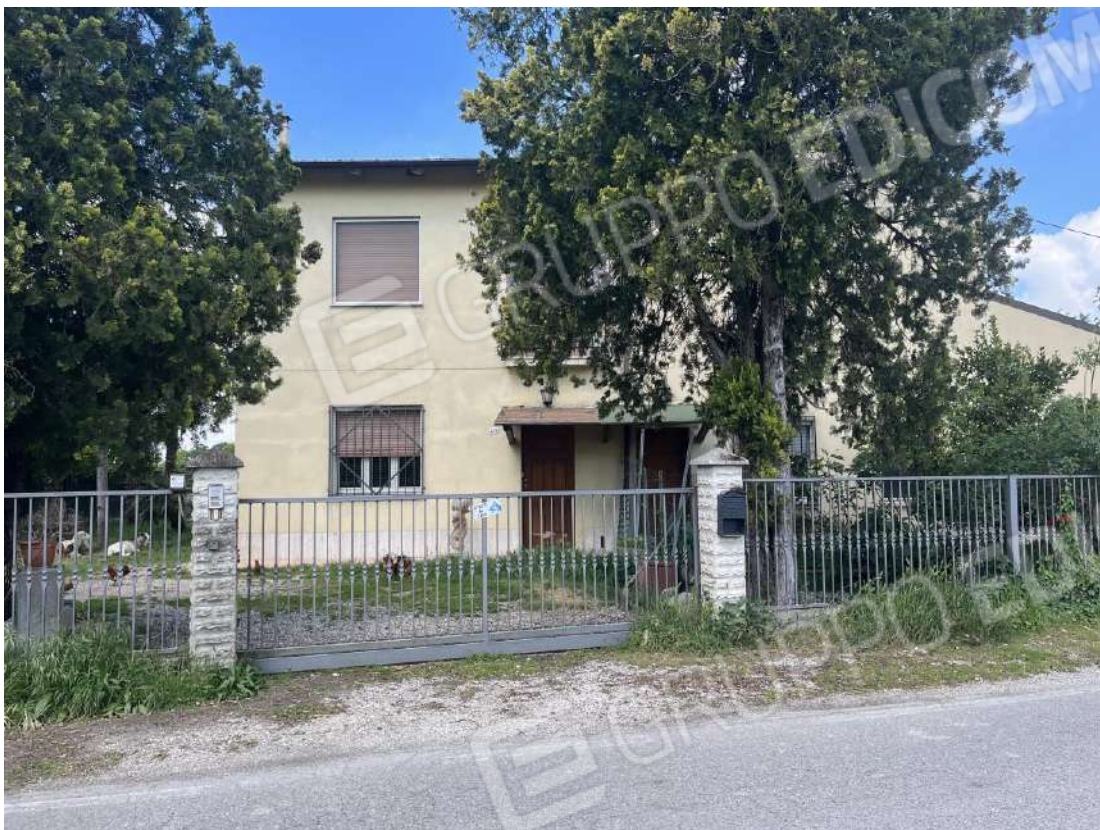
Fabbricato da via Santerno Ammonite
