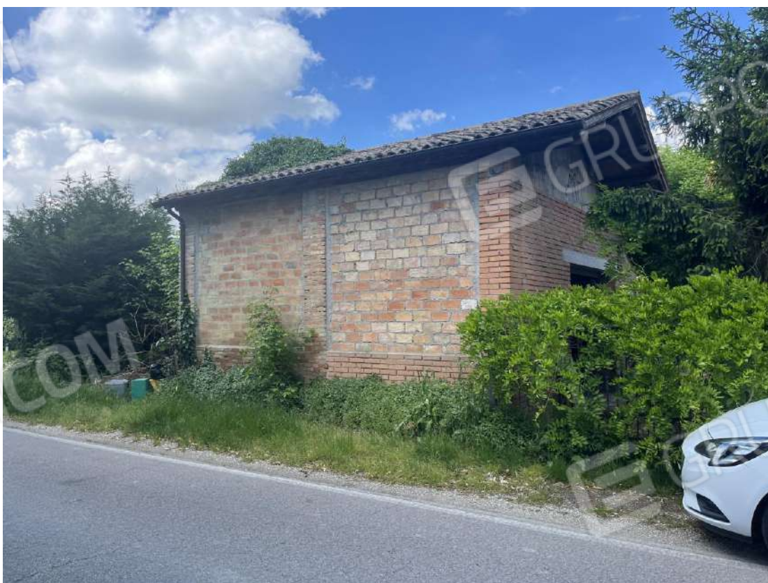
Fabbricato servizio da via Santerno Ammonite
