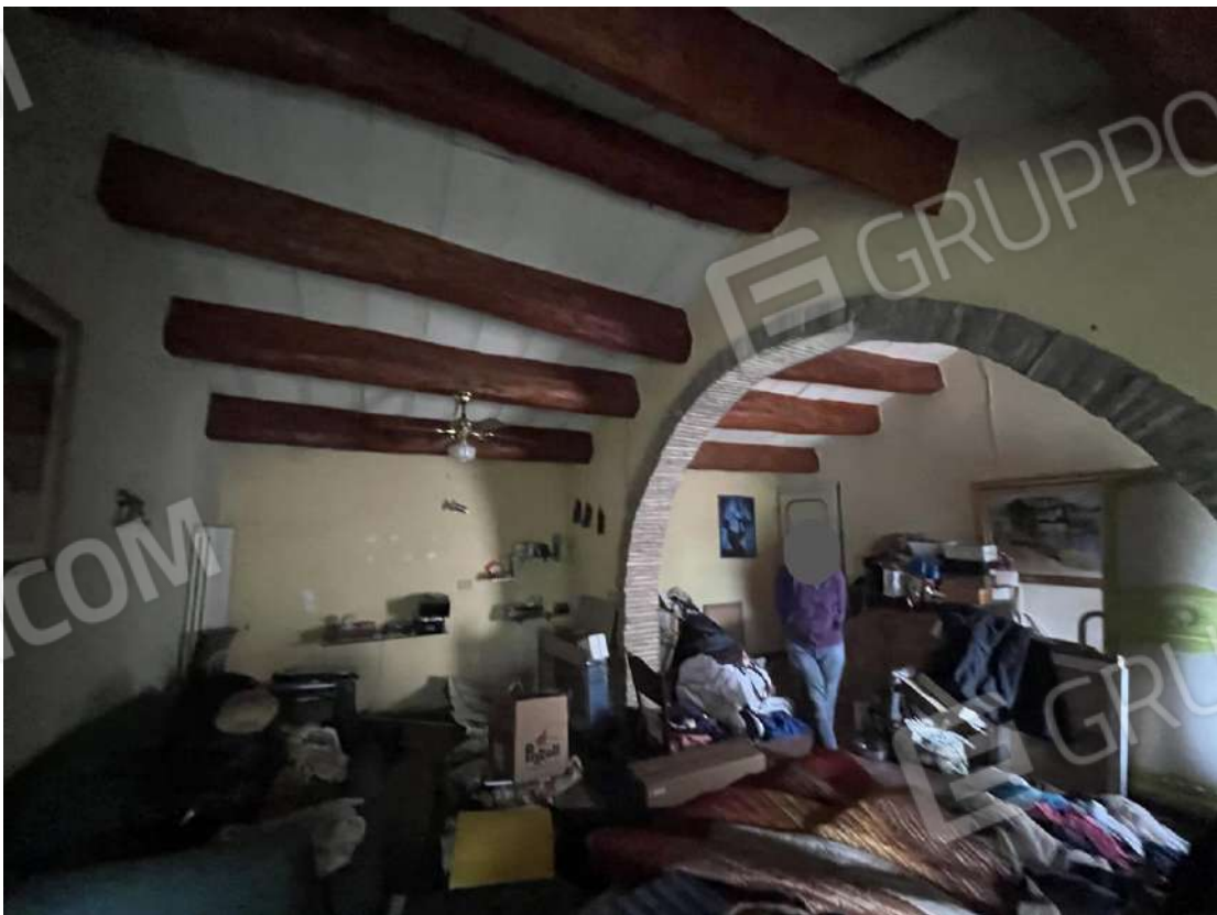
Ripostiglio piano primo
