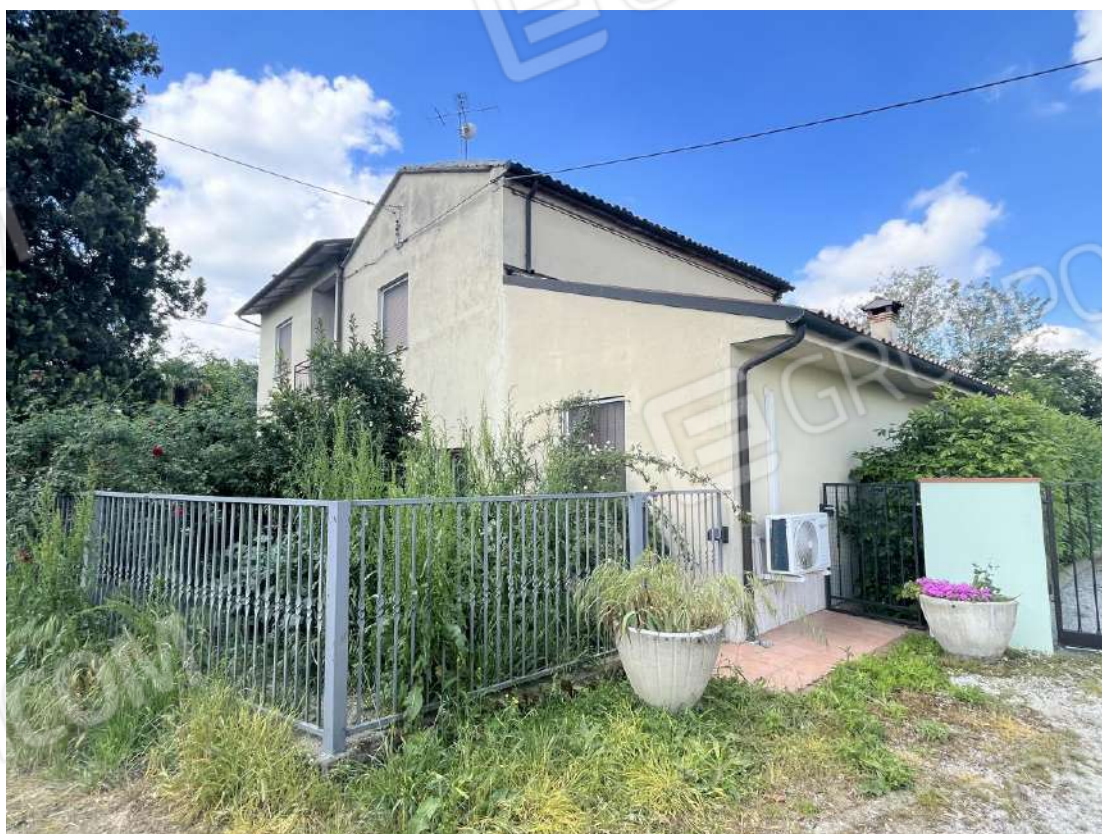
Fabbricato da via Santerno Ammonite
