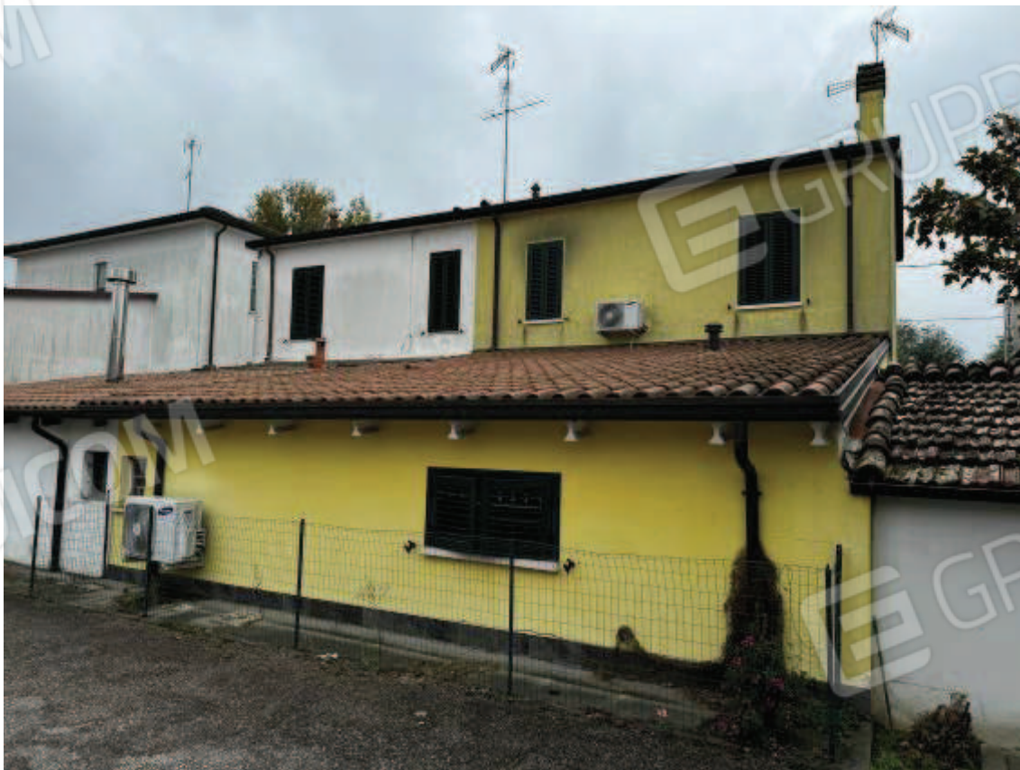
Foto 4: Fronte su via dei Ponticelli
