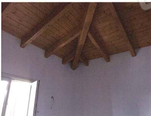
Villetta E12- Vista interna, soffitto piano primo
