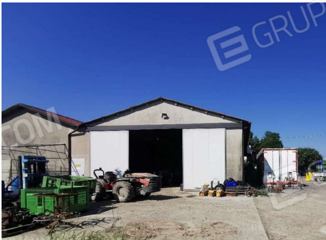
Vista esterna capannone (F.127 Part.206 Sub.5)
