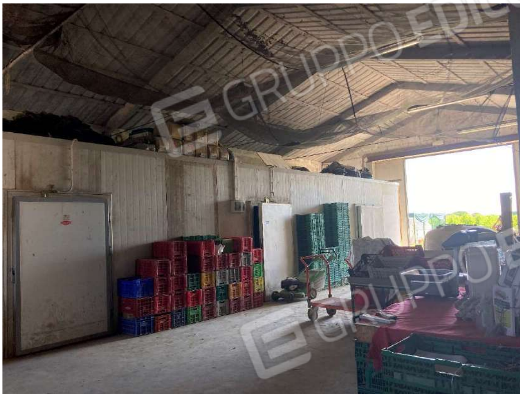
Vista interna capannone (F.127 Part.206 Sub.5)
