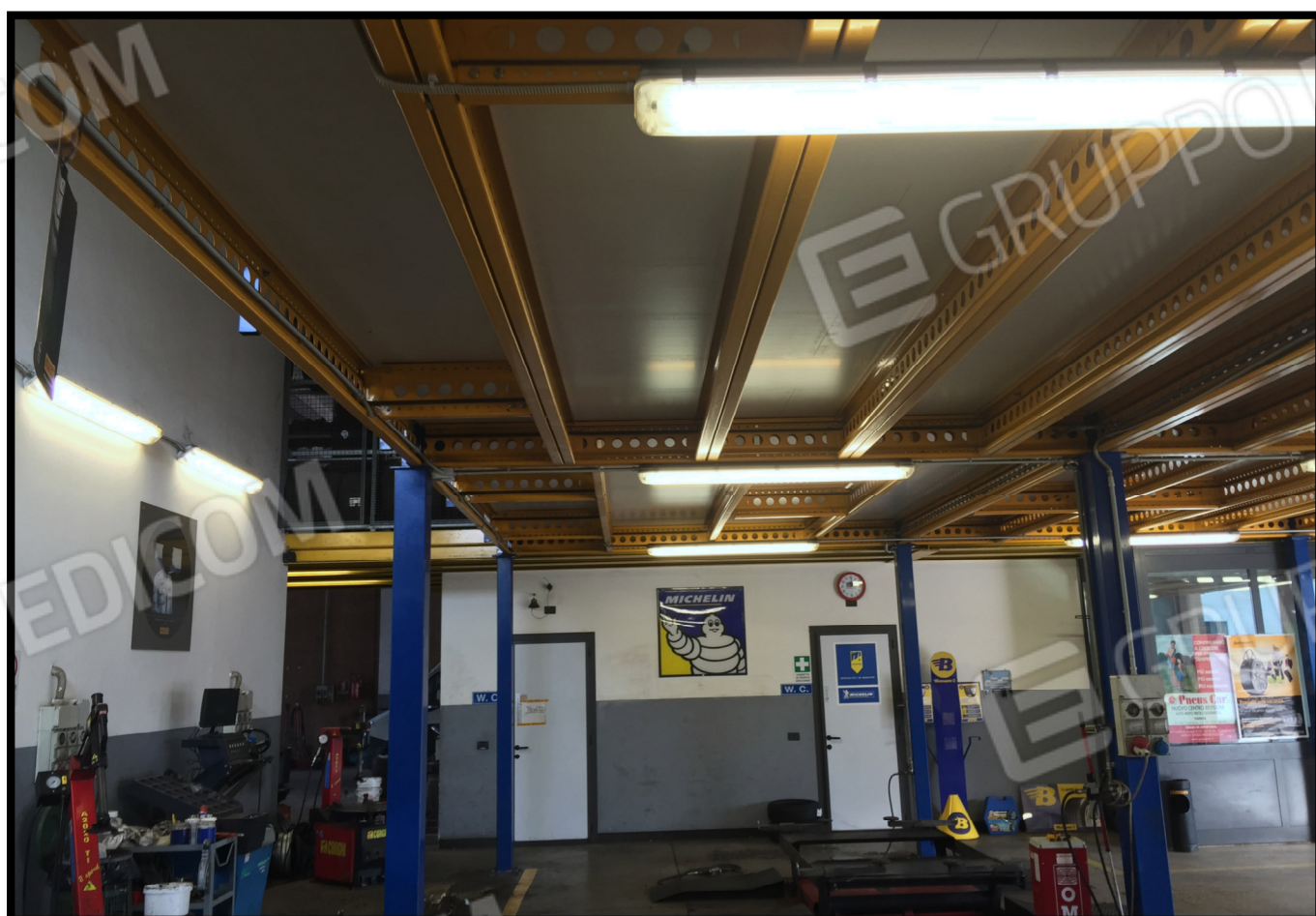
Officina autovetture a piano terra
