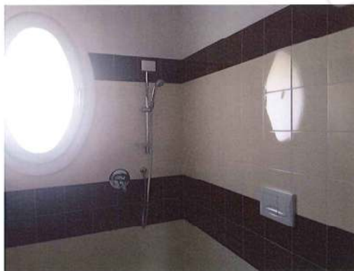
Villetta E13- Vista interna, bagno piano terra
