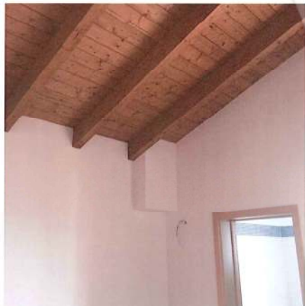
Villetta E13- Vista interna, soffitto piano primo
