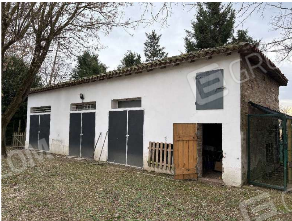
FOTO 15: FABBRICATO SECONDARIO (SERVIZI/GARAGE)
