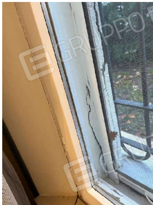
FOTO 45 e 46: SUB. 9 – PARTICOLARI CREPE AL PIANO TERRA
