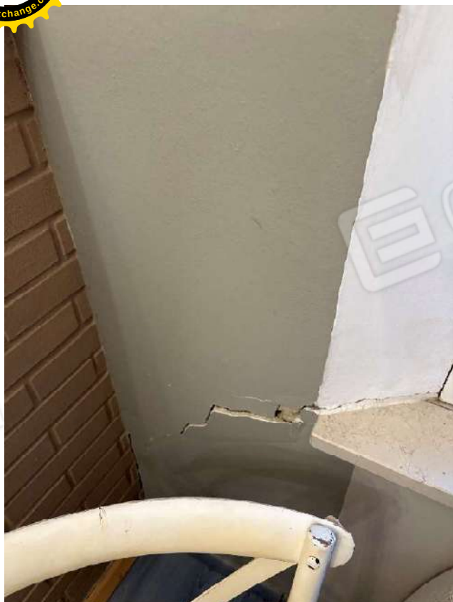
FOTO 43 e 44: SUB. 9 – PARTICOLARI CREPE AL PIANO TERRA
