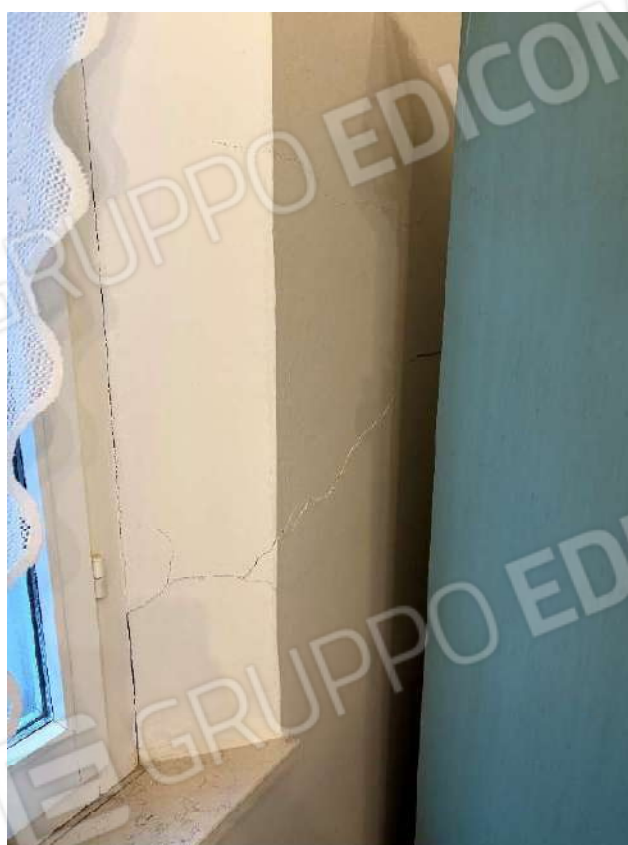
FOTO 43 e 44: SUB. 9 – PARTICOLARI CREPE AL PIANO TERRA
