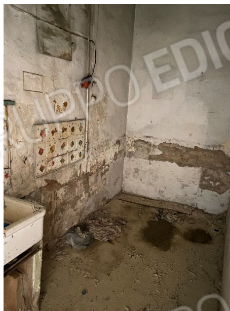
Sub. 8 – locale cucina PT (foto n. 2)
