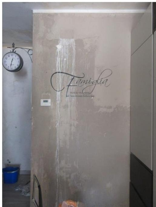
1. Infiltrazione nel primo solaio nella zona della cucina dovuta al bagno posto al piano primo. Tale infiltrazione al primo sopralluogo del 28/04/2023 non era presente.
