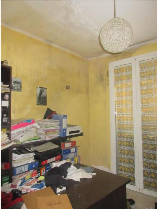
3. Infiltrazione dal secondo solaio nella camera da letto lato nord-ovest dovute al bagno posto al piano sottotetto con visibili muffe dovute ad una scarsa aerazione dei locali.
