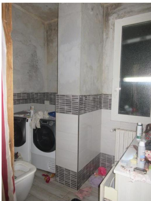
2. Infiltrazione dal primo solaio nella zona del bagno dovute al bagno posto al piano primo con visibili muffe già presenti al primo sopralluogo
