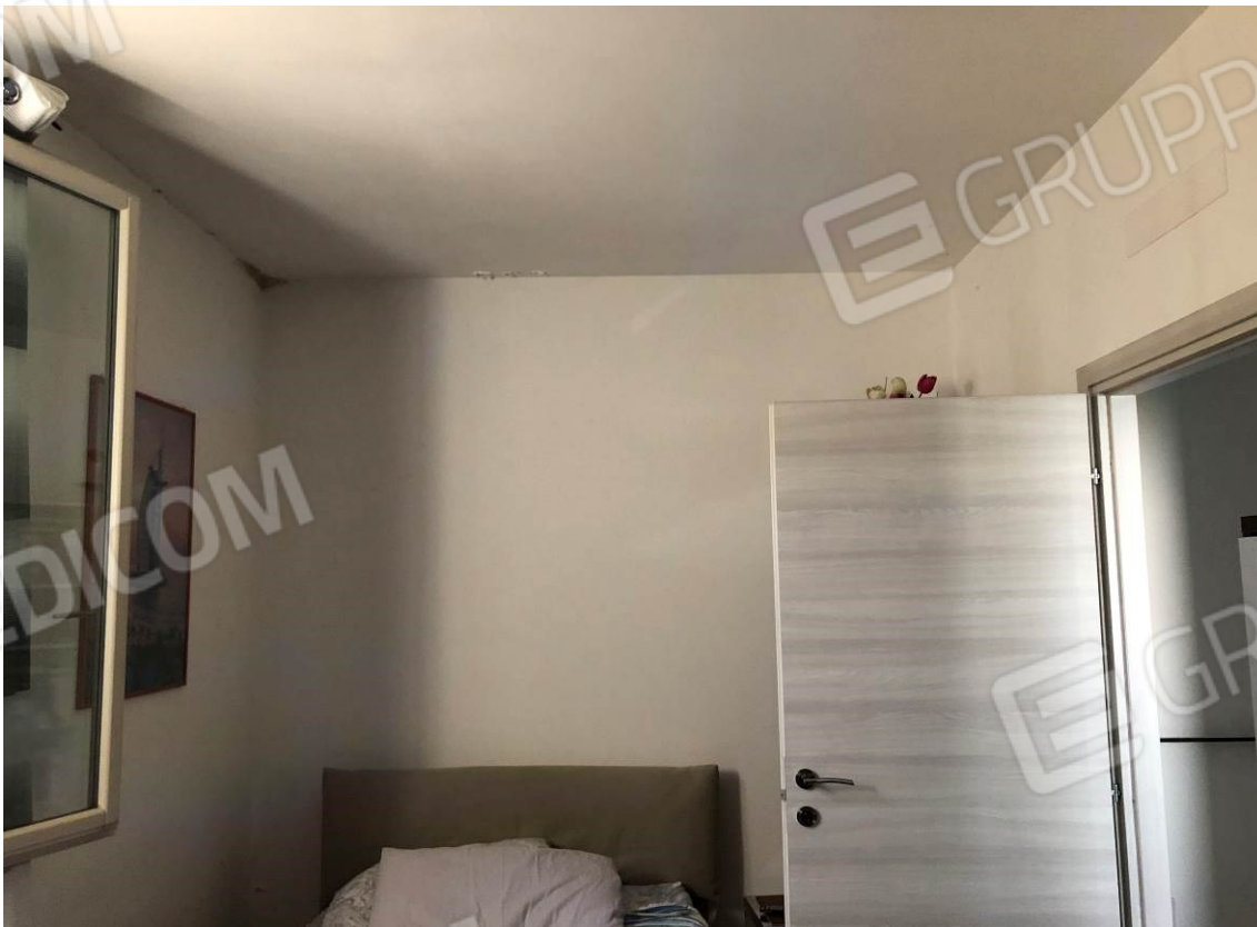
Foto 16 – Interno abitazione – camera 2 P1.
