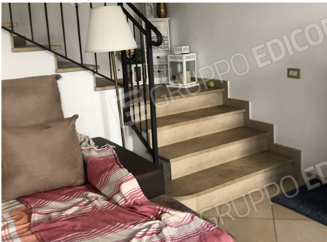
Foto 11 – Interno abitazione – particolare rampa scala PT-P1.
