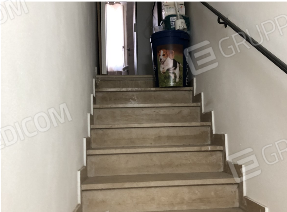
Foto 14 – Interno abitazione – Particolare scala PS1-PT.
