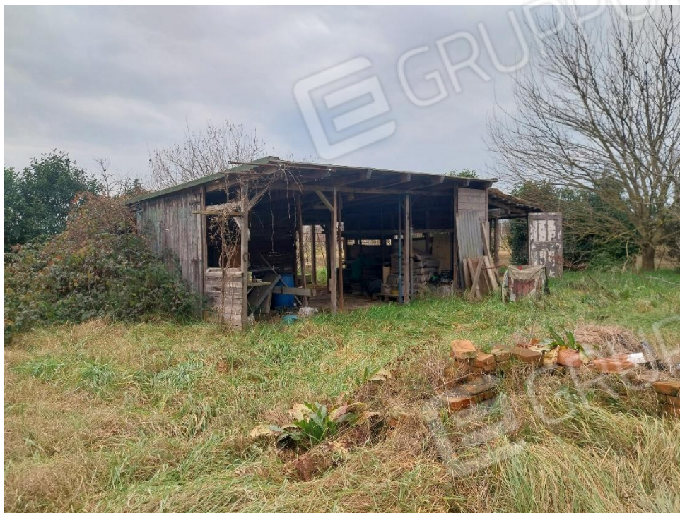
Foto 27. Manufatto da demolire
