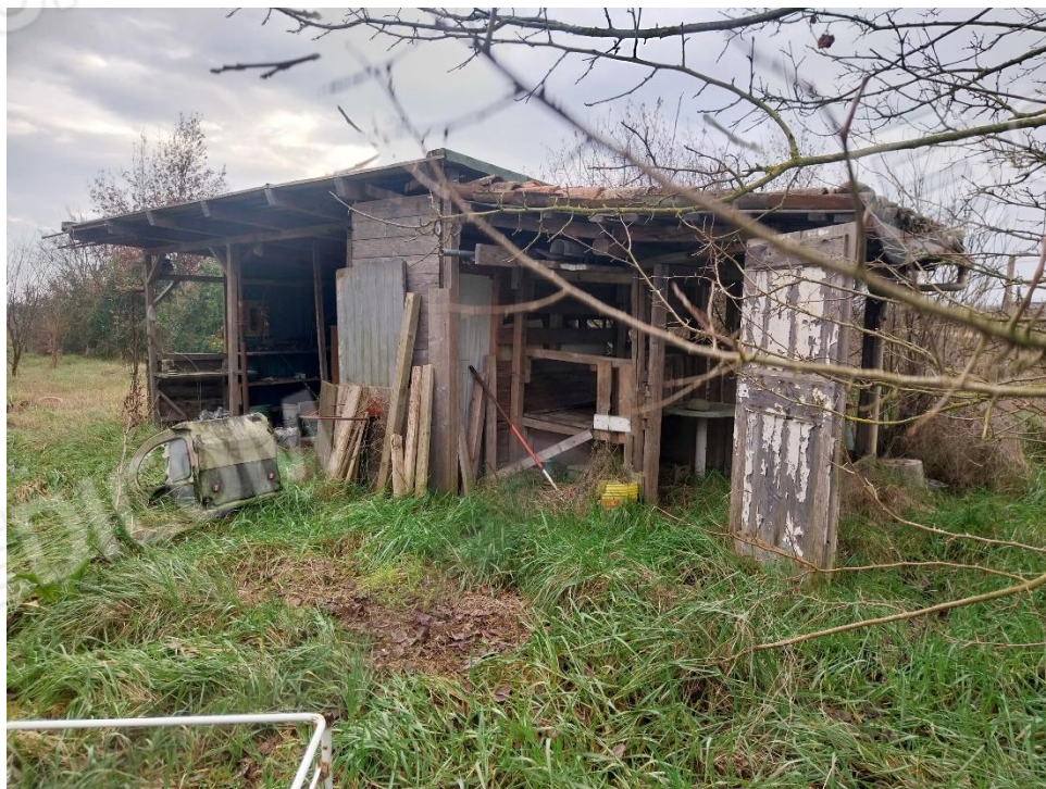
Foto 27. Manufatto da demolire
