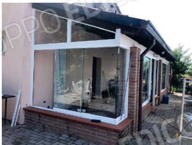
Foto 6- immobile B e foto 6 bis del 13-7-23 installazione infissi a chiusura portico
