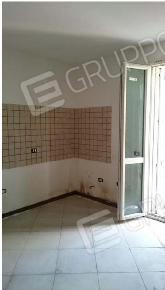
ALLOGGIO SUB 29 P.1° ANGOLO COTTURA CON PRESENZA DI UMIDITA'
