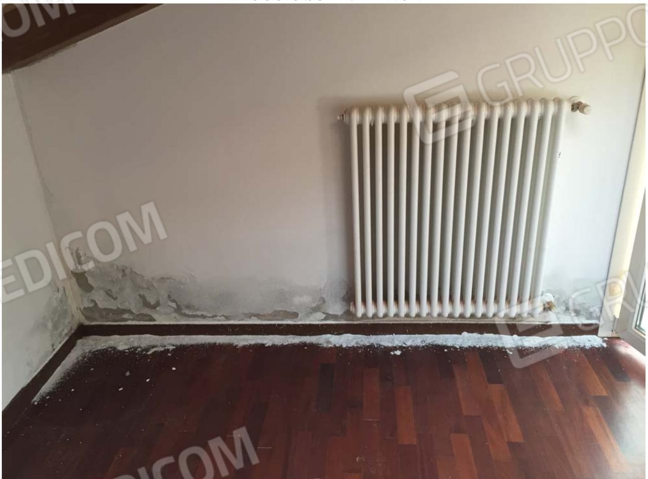
ALLOGGIO SUB 17 (PRESENZA DI UMIDITA' E INFILTRAZIONI)
