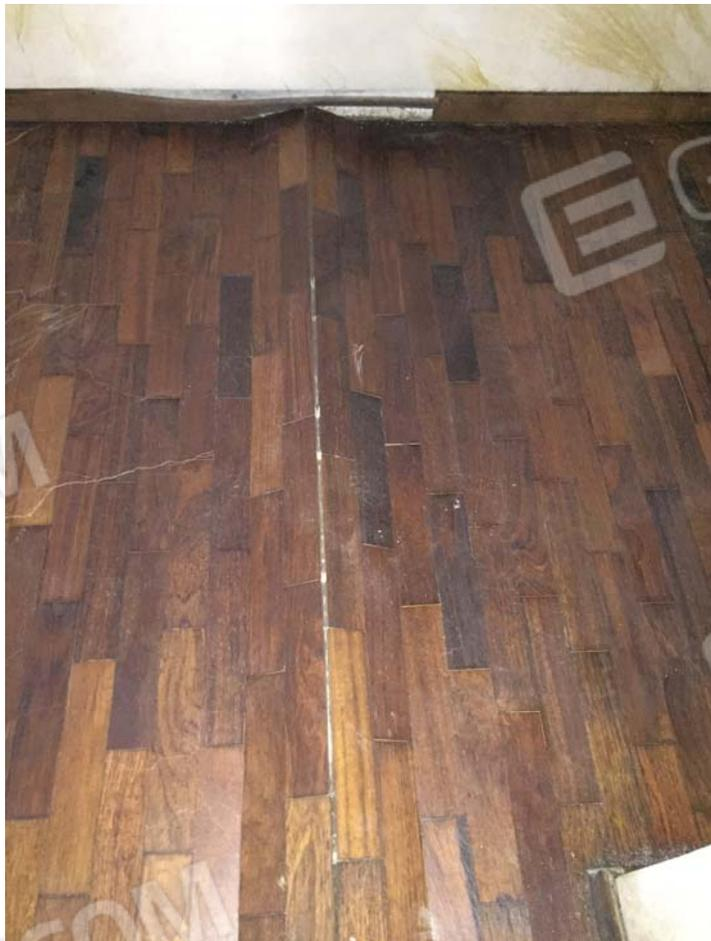
ALLOGGIO SUB 22 (PAVIMENTO IN LEGNO SOLLEVATO PER EFFETTO UMIDITA')
