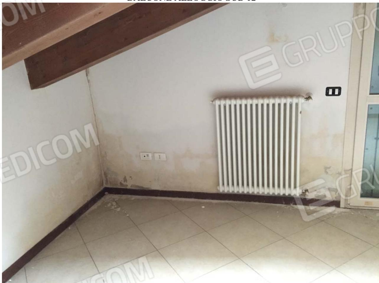
ALLOGGIO SUB 15 PIANO 2° (PRESENZA DI UMIDITA' E INFILTRAZIONI)
