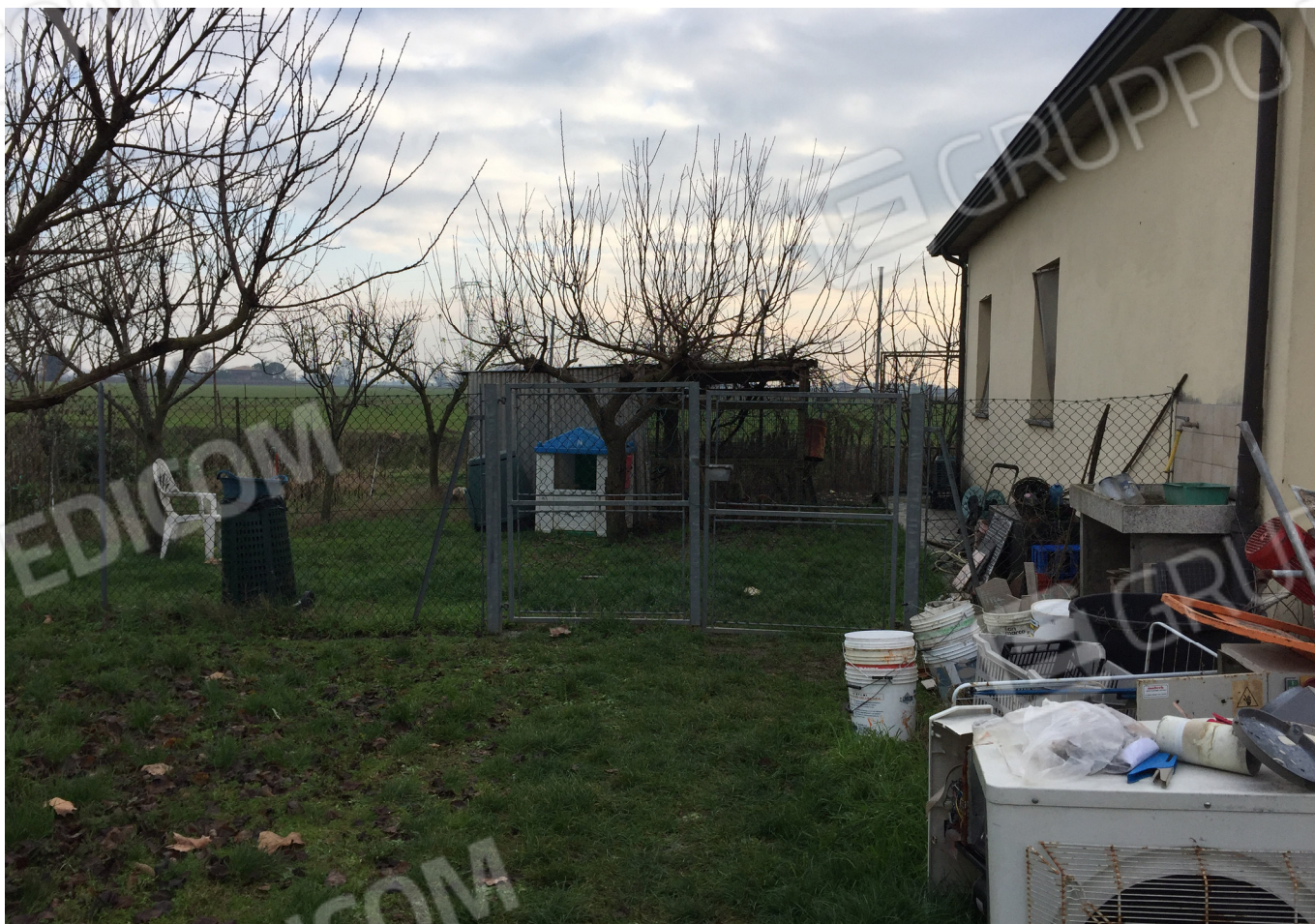
Foto 10 - Recinzione interna alla corte di pertinenza
