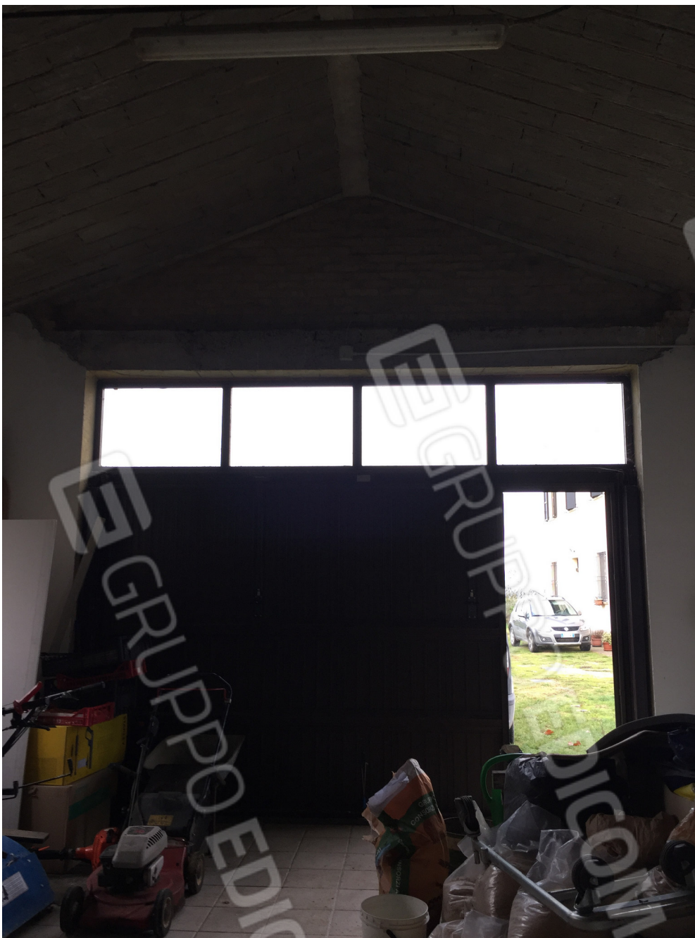
Foto 13 - Portone carrabile/pedonale corpo servizi
