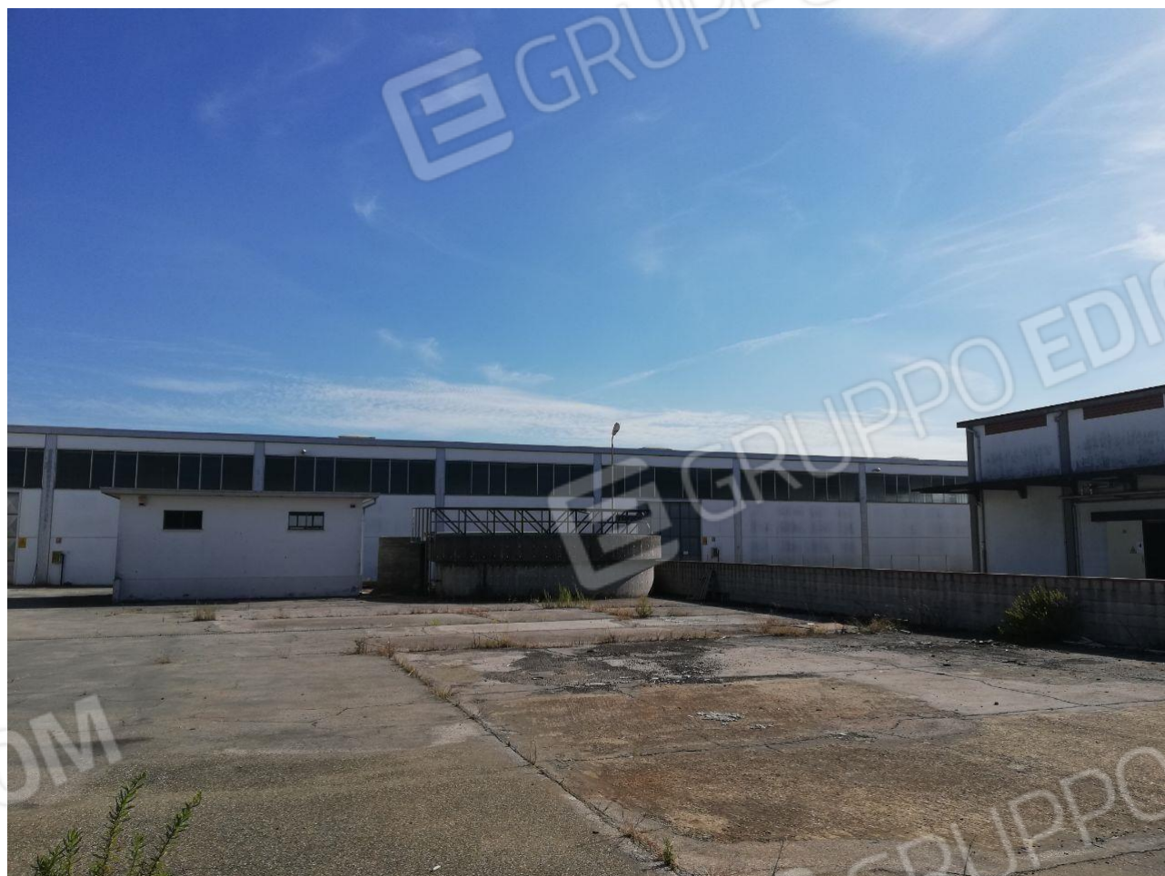
Figura 1 VISTA ESTERNA LOTTO 2
