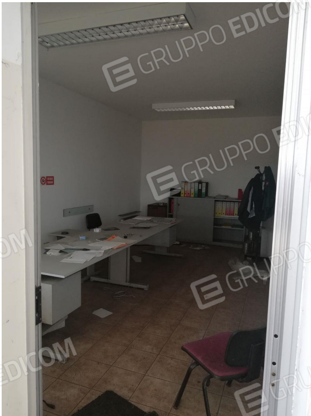
Figura 6 INTERNO FOGLIO 103 MAPP. 257 SUB 7
