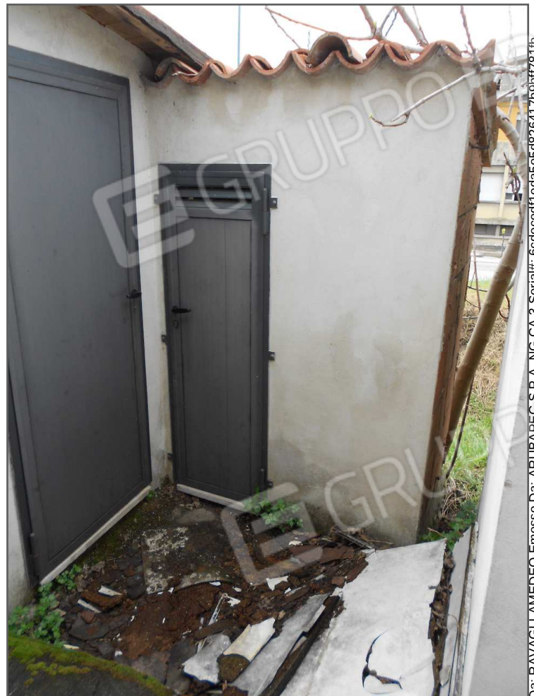
Ripostiglio nella piccola area esterna
