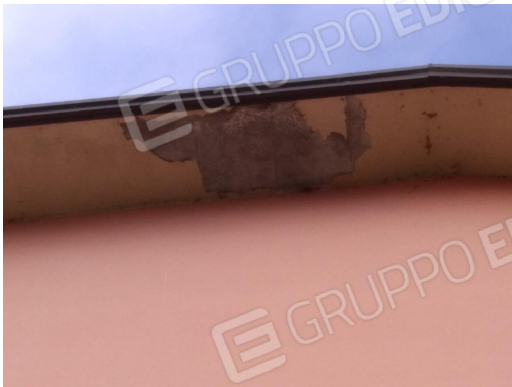
18. Segni di infiltrazioni in copertura, comunque esterne al perimetro.
