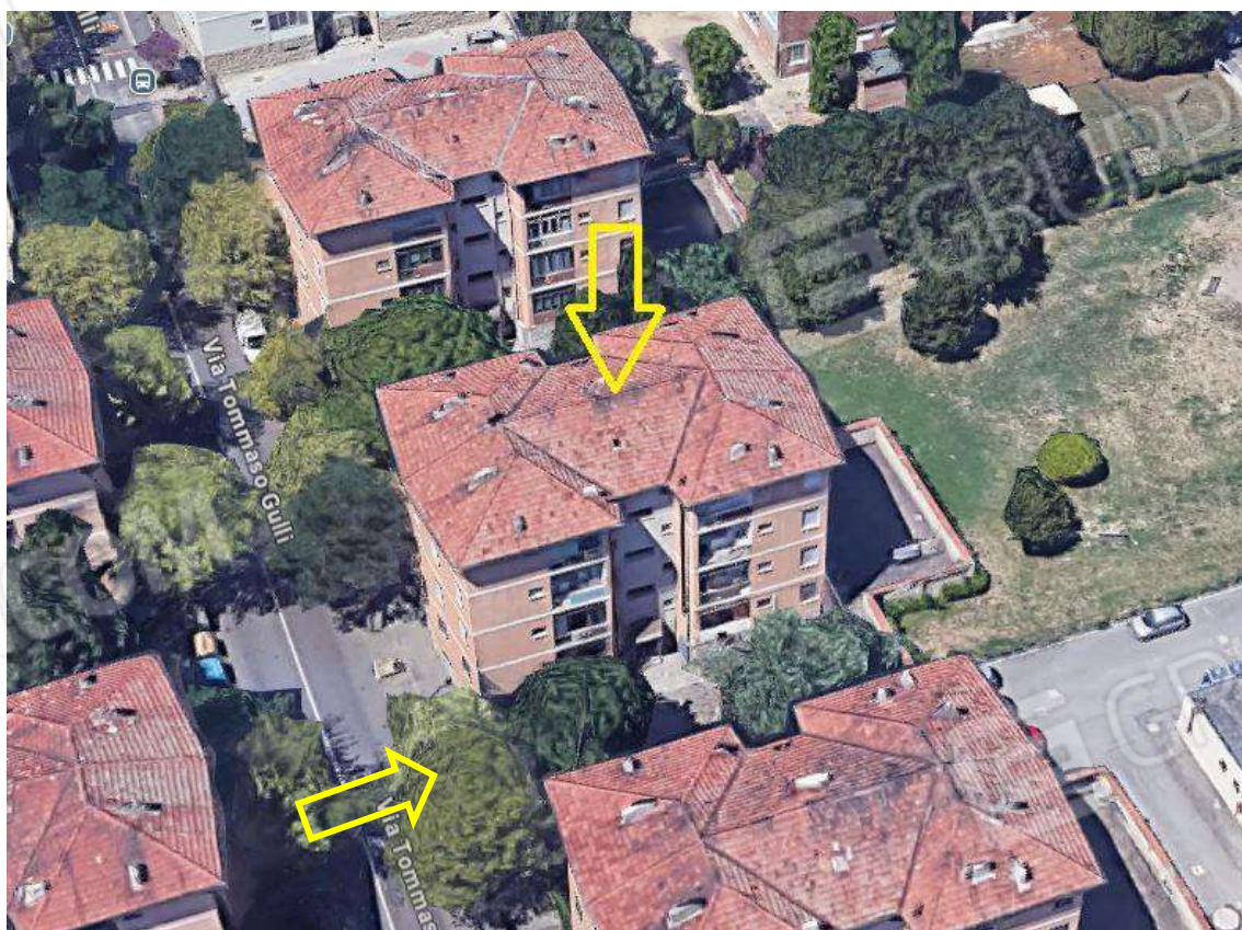
IMMAGINE SATELLITARE 3D VISTA PROSPETTO EST DELLA PALAZZINA INDICAZIONE INGRESSO VIA T. GULLI N. 110
