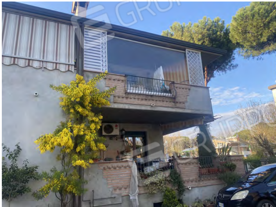
Foto 1 esterno lato sud
