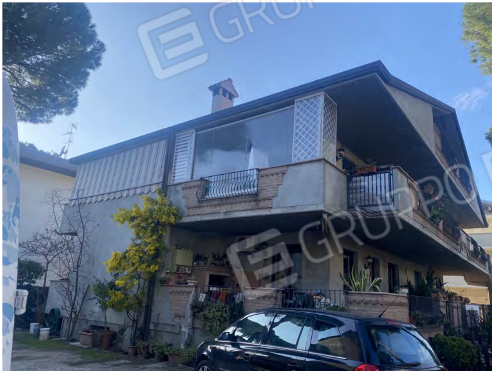
Foto 1 esterno lato sud-est
