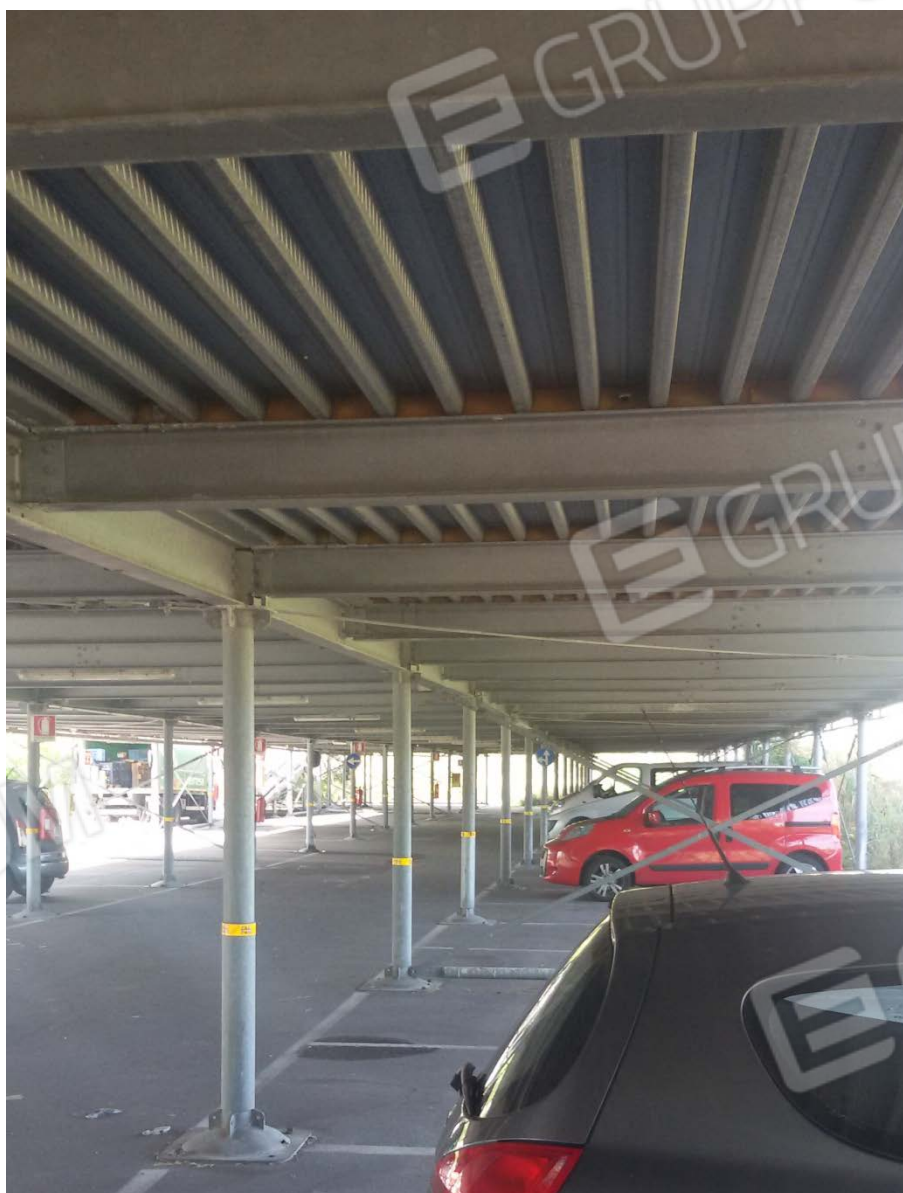
Fotografia 4 – Lotto 2 – Parcheggio Piano Terra
