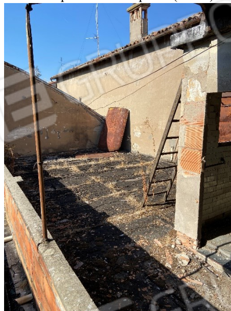
Sub .13 – terrazzo P1 (foto n. 1)
