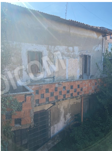
Sub. 13 – terrazzo P1 (foto n. 2)
