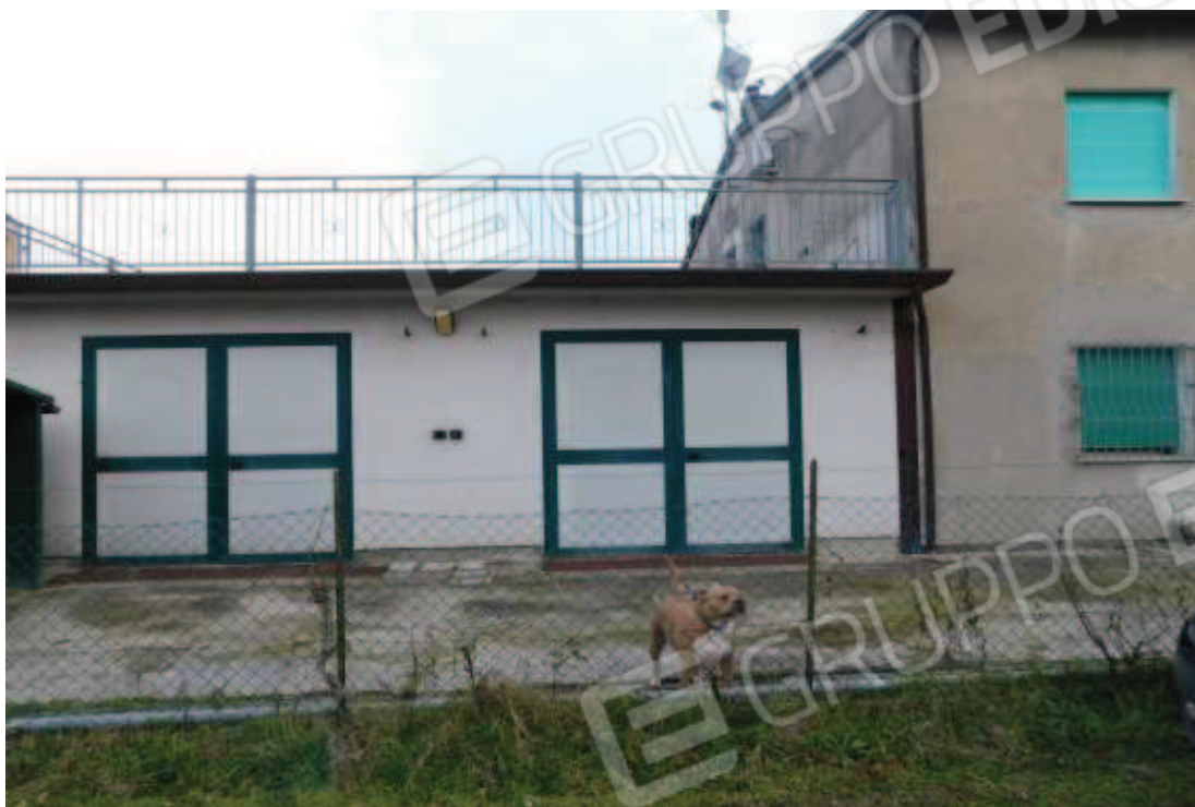
Foto 22 – Vista ingressi carrabili Autorimessa dall'esterno.
