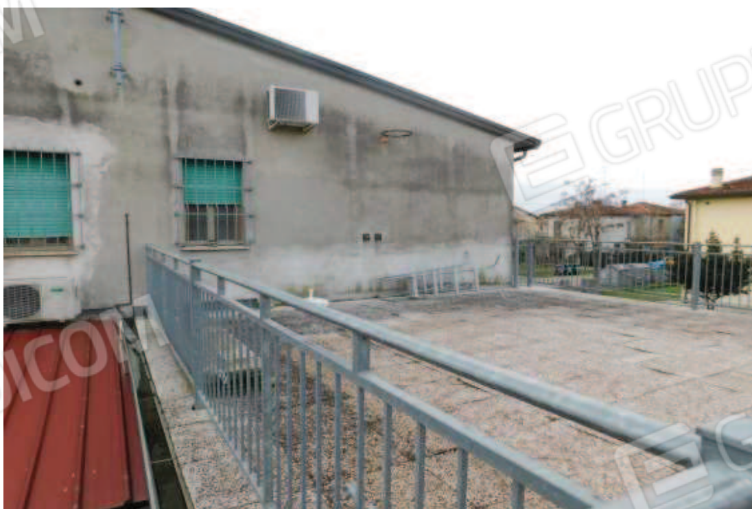
Foto 27 – Particolare lastrico solare (non autorizzato).
