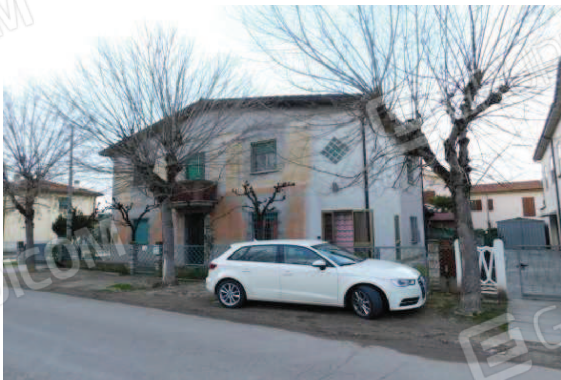
Foto 2 – Vista del fabbricato da Via Paolo Fabbri.
