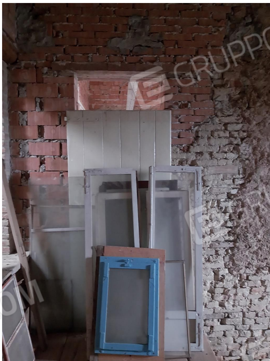
Foto 20. Ballatoio piano primo
