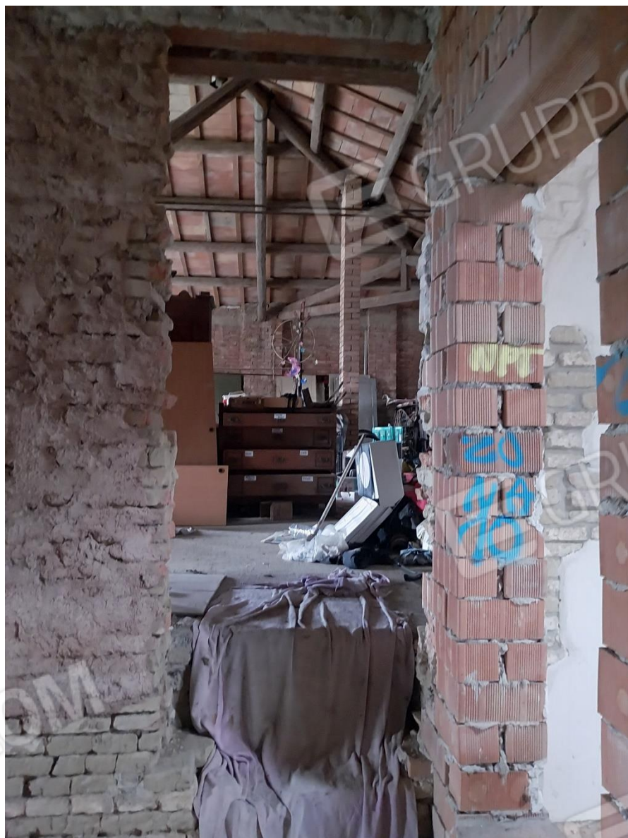
Foto 19. Ballatoio piano primo
