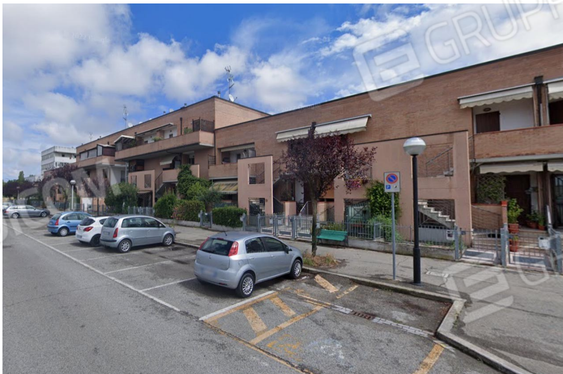
Vista generale dell'edificio fronte strada.
