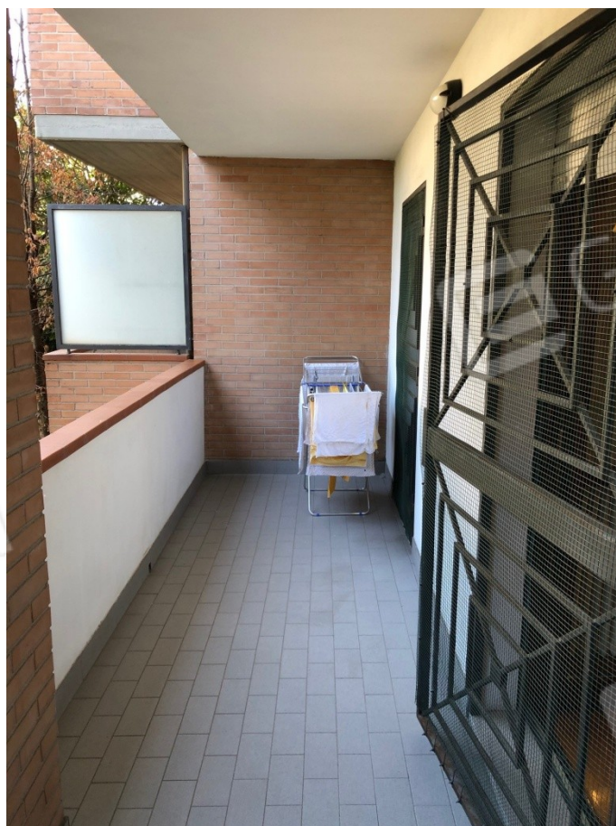
Vista portico al piano terra/rialzato
